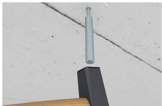
4. Dübel mit Spreizwerkzeug verankern
