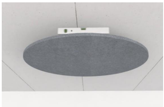
9. Deckensegel ausrichten, auf gewünschte Abhanghöhe achten. Fertig!
