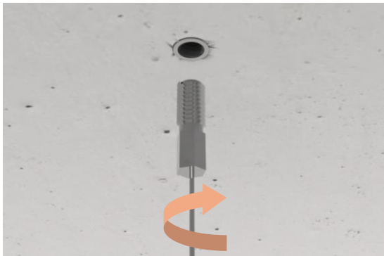
5. Drahtseile in die Einschlagdübel eindrehen
