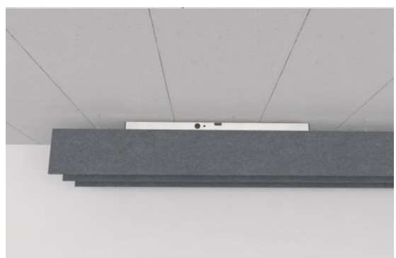
10. Baffeln ausrichten, auf gewünschte Abhanghöhe achten. Fertig!
