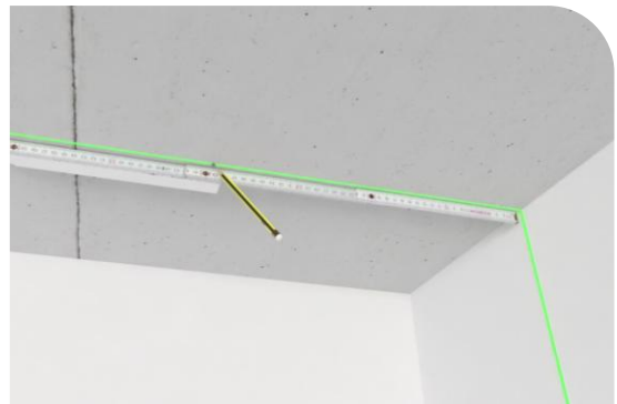
1. Bohrlöcher an Decke anzeichnen
