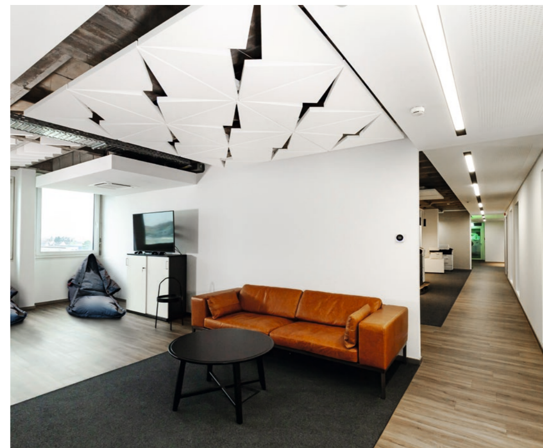
FAP EF Abhängung mit Drahtseilen Deckensegel, abgehängt an Drahtseilen
