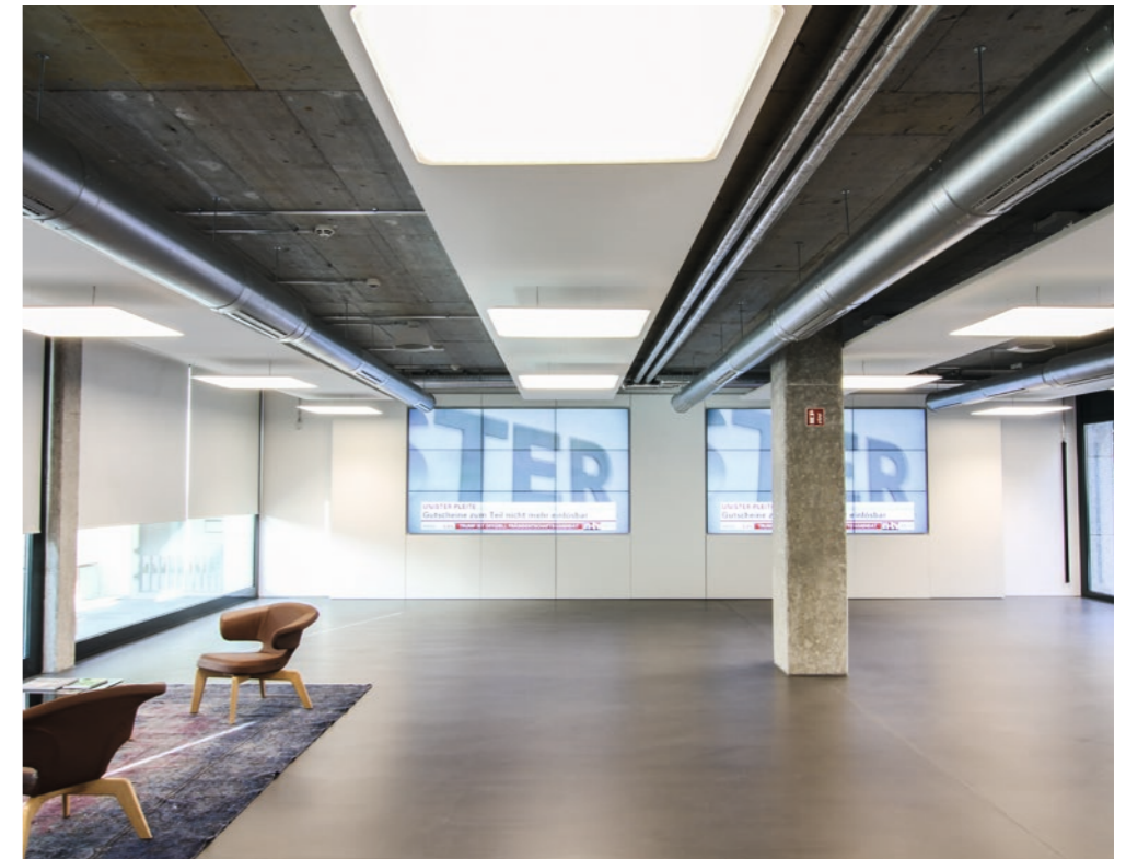
FAP E an GFAG SYS-C-Profilen mit Drahtseilen abgehängt
