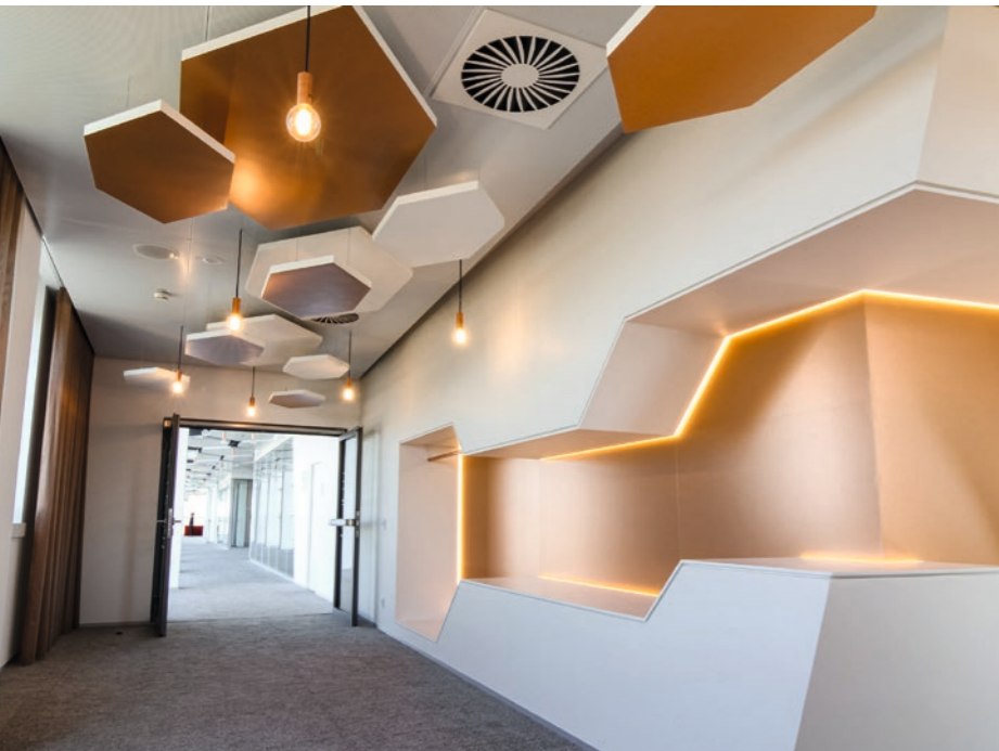
FAP EF in Freiform Deckensegel, abgehängt an Drahtseilen
